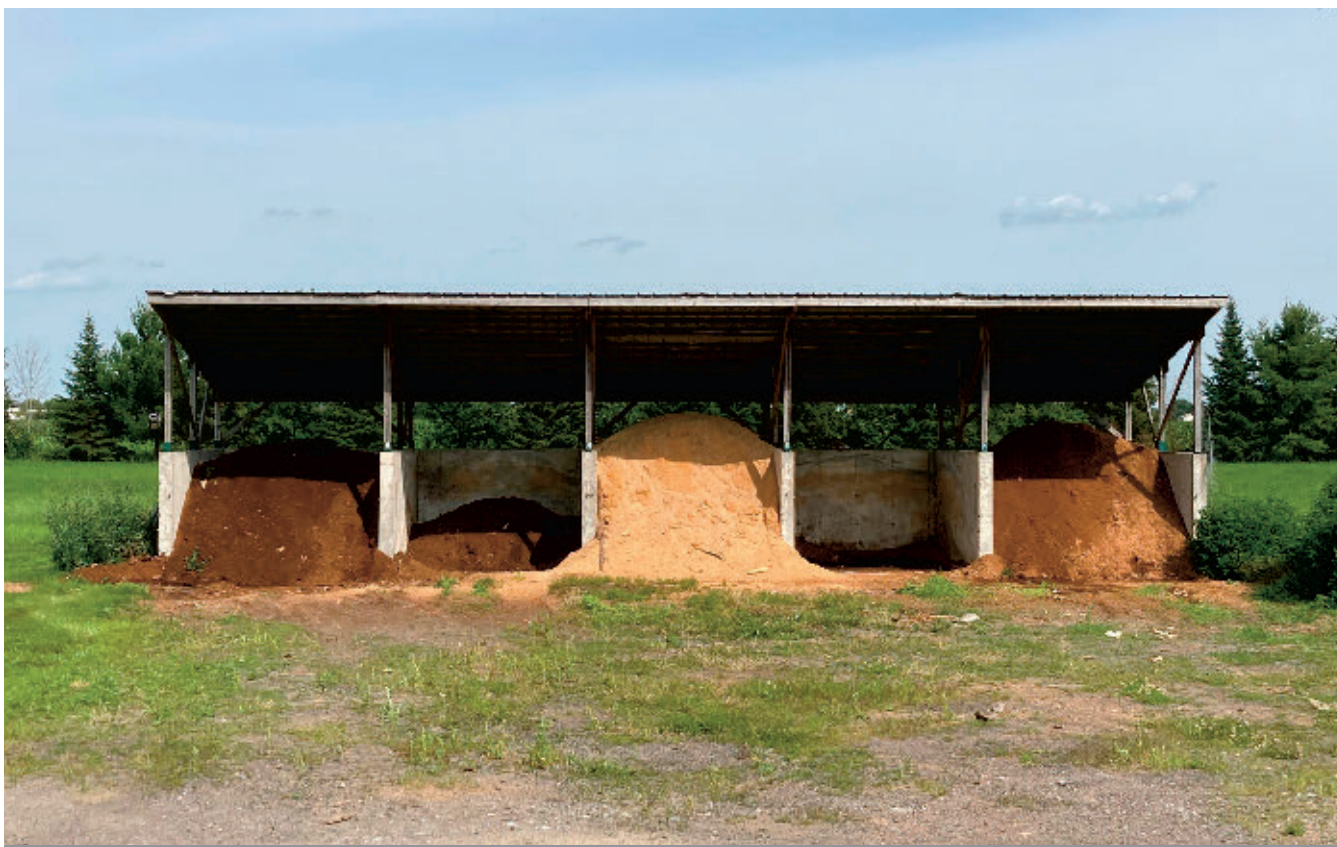
Quatre cellules servent au compostage, tandis qu'une sert à entreposer la sciure de bois, matière favorisant le compostage des animaux.
