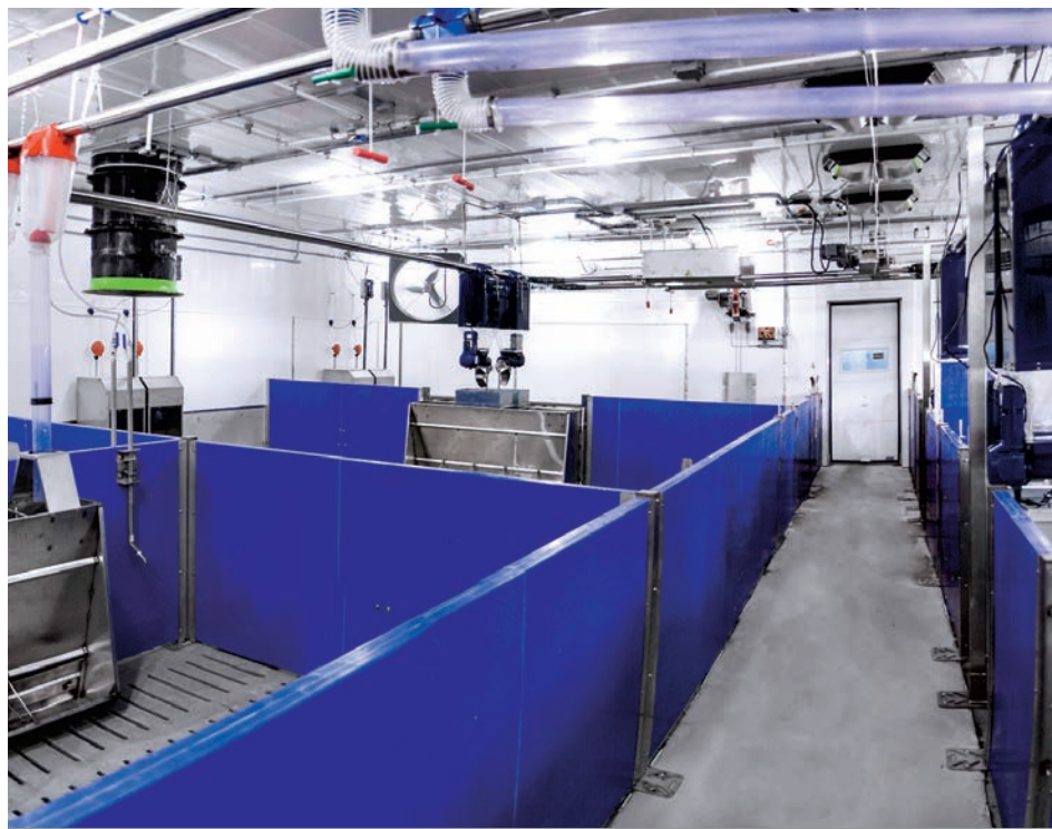
La quarantaine a été construite à l'intérieur de la maternité avec toutefois une pression d'air différente du reste du bâtiment.
