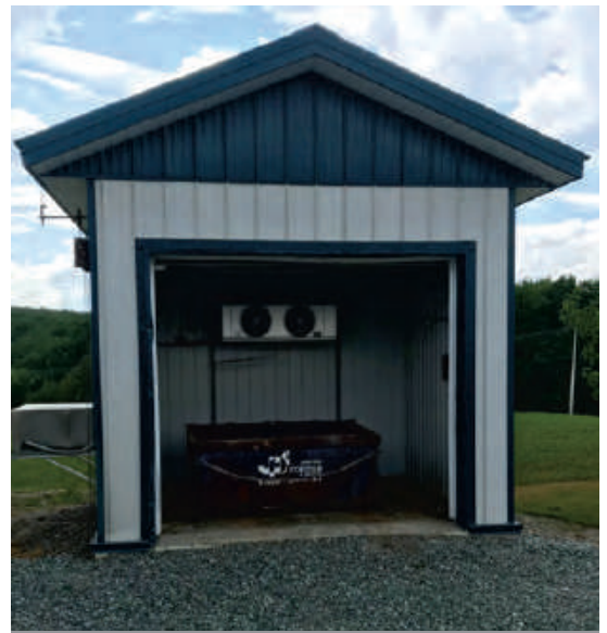
Une porte de garage referme le cabanon pour dissimuler le bac et conserver la température de l'unité de réfrigération.
