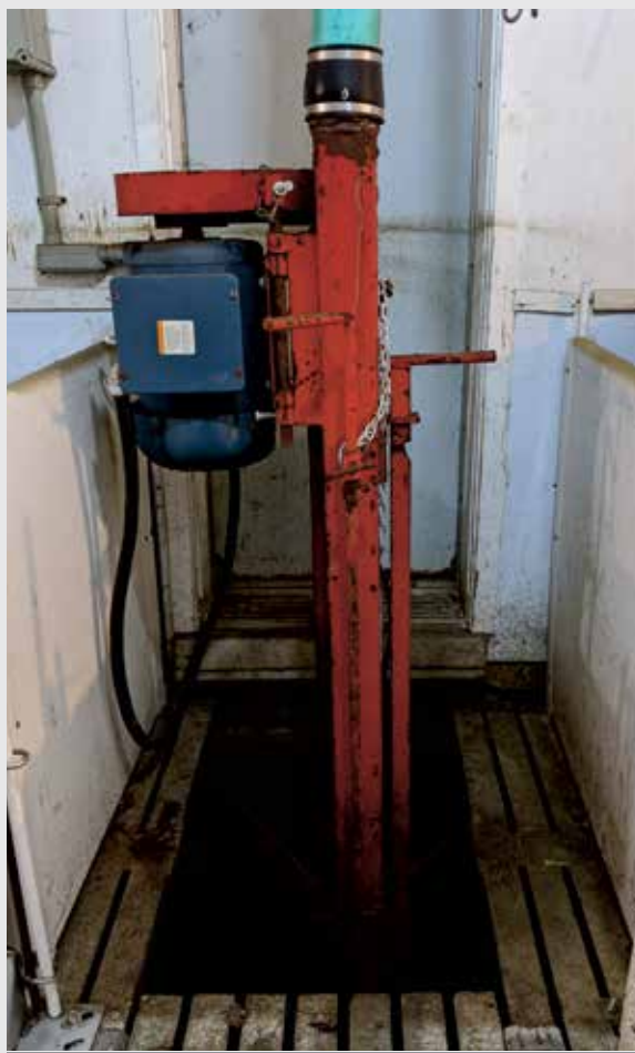
Pompe à colonne facile à retirer des structures d'entreposage.
