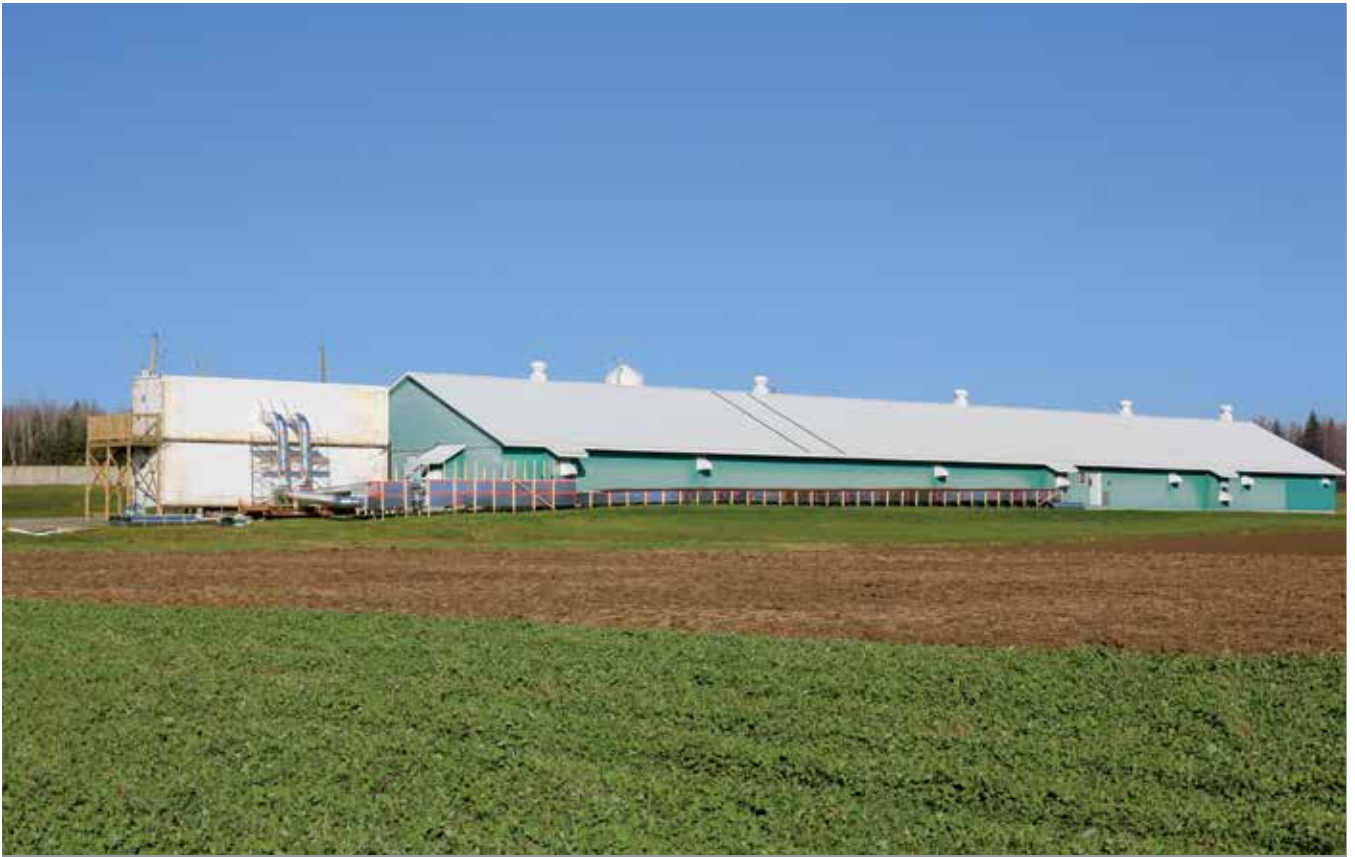
Unité pilote de traitement d'air de l'IRDA (voir « lavage de l'air » au tableau 1).
