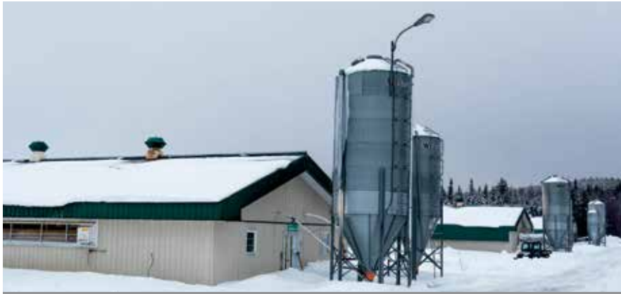
L'un des trois bâtiments est équipé d'un système de ventilation naturelle offrant un environnement de travail plus agréable en été.
