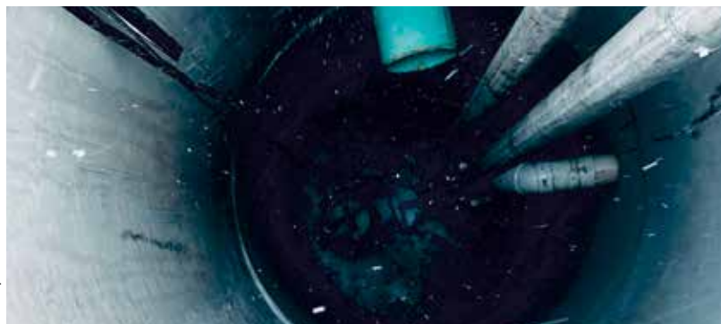
Exemple de pompe submersible sur coulisseau dans une préfosse préfabriquée.
