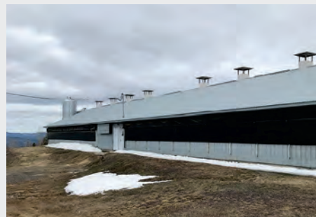
L'engraissement à ventilation naturelle situé sur la ferme de Bernard Néron, dans Charlevoix.
