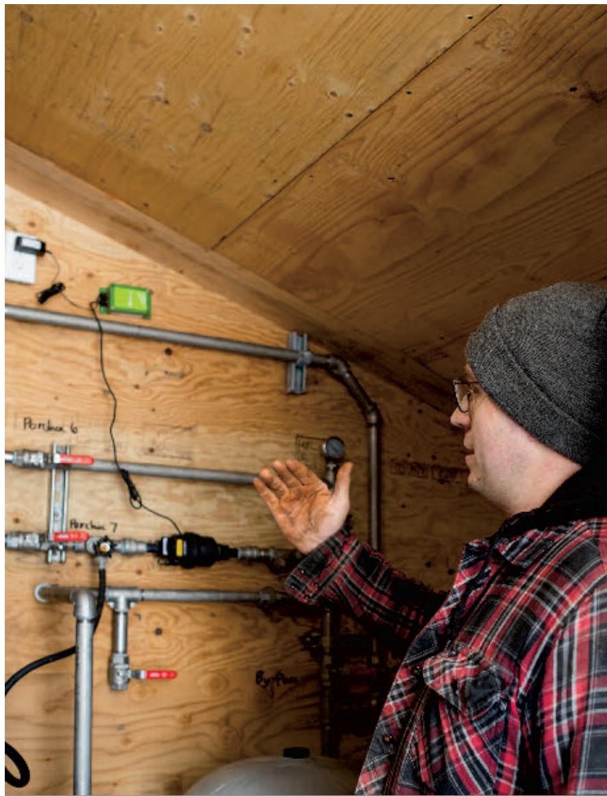
Jérémie Leclerc, conjoint et associé de Jessika, devant un des systèmes de gestion des équipements basé sur l'intelligence artificielle. Ici, il s'agit du compteur d'eau intelligent qui sert à calculer la consommation d'eau et qui envoie des rapports journaliers. Il transmet aussi une alarme en cas de baisse de consommation ou hausse inhabituelle.
